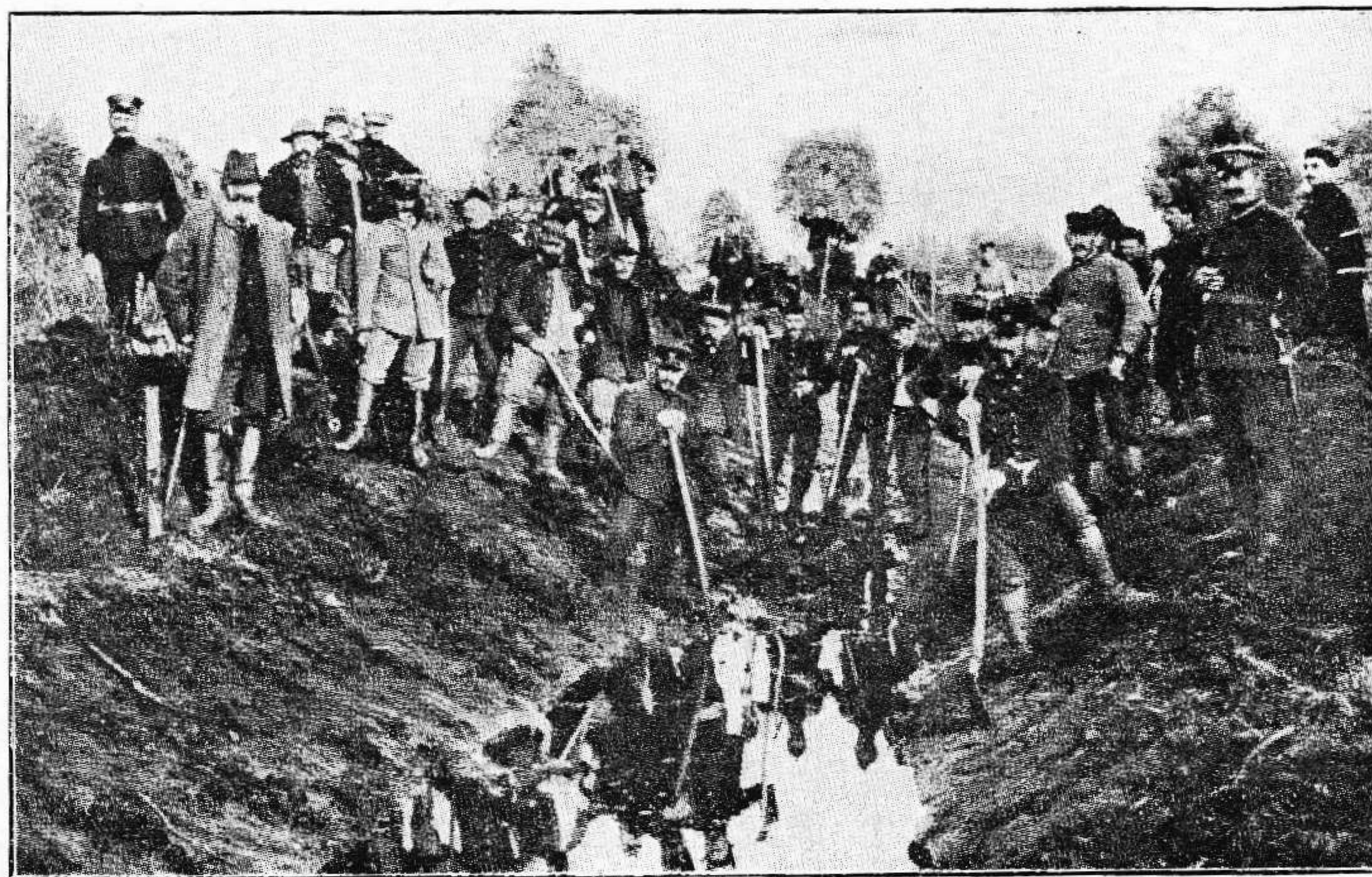
Camp de Soltau (colonie de Lichtenhorst). Prisonniers occupés à des travaux de terrassement et d'assèchement des marais.
